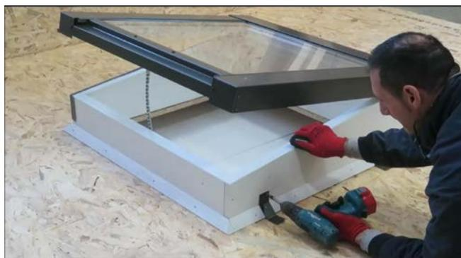
2) Fissare la finestra alla soletta con le apposite zanche fornite in dotazione. Controllare poi, dall'interno, che il perimetro di appoggio della finestra sia ugualmente ripartito nei 4 lati.
