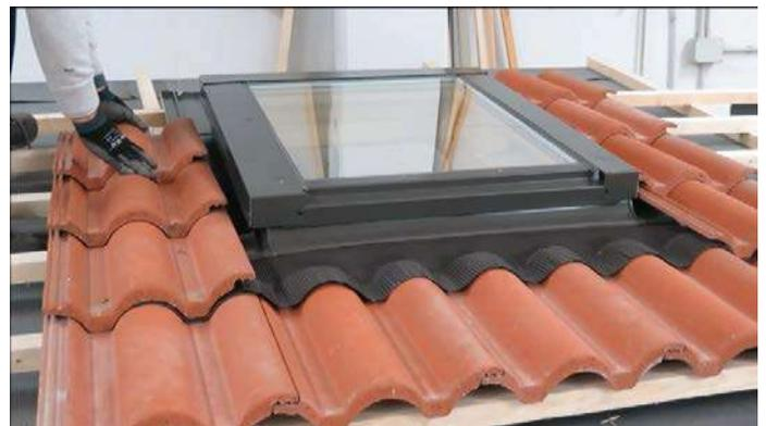
Le tegole vanno disposte sotto il fondo, nella parte bassa della finestra. Vanno disposte invece sopra la testata e i raccordi laterali.
