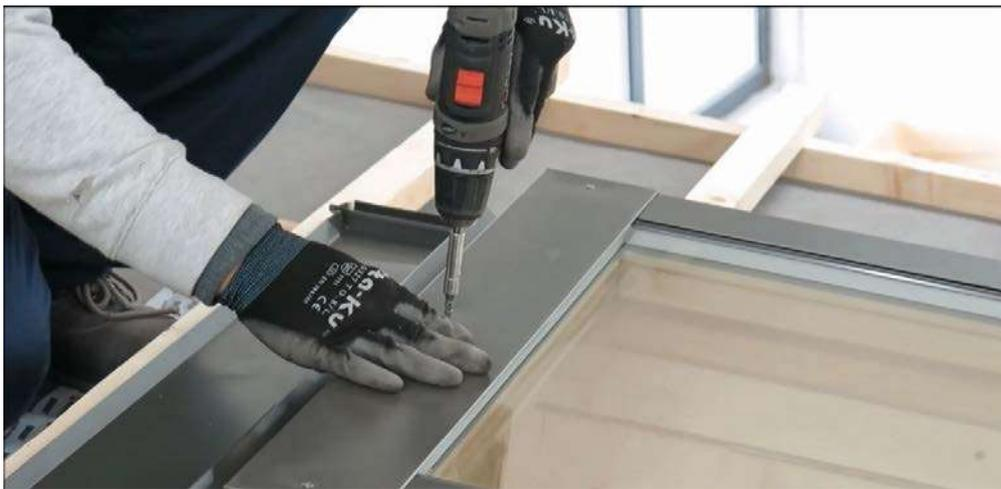
6. Avvitare il carter superiore sopra la testata usando i fori già esistenti. Fare attenzione che il deviatore di flusso indicato dalla freccia nell'immagine di fase 5, rimanga esterno.
