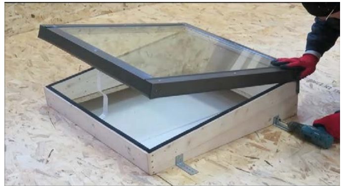
2. Fissare la finestra alla base di appoggio con le zanche e le viti in dotazione
