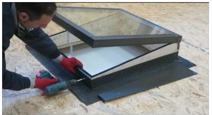
4. Fissare i carter di alluminio sopra la guaina con le viti in dotazione
