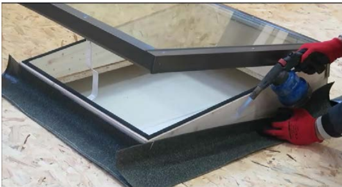
3. Attaccare la guaina ai 4 lati della finestra per coibentare il serramento (va bene qualsiasi guaina impermeabile specifica per tetti). Assicurarsi con estrema attenzione che la guaina sia applicata con cura e non vi siano eventuali spazi o sormonti che permettano l'infiltrazione di acqua o aria.
